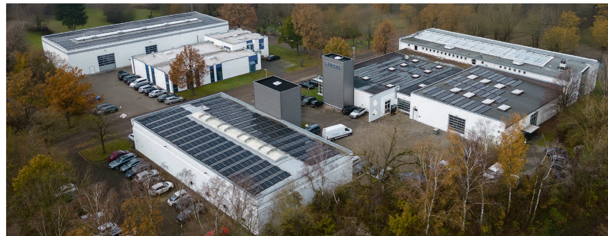
In den vergangenen 30 Jahren wuchs der Standort in Meißen. Inzwischen arbeiten Verwaltung und Produktion auf einer Gesamtfläche von 5.500 Quadratmetern. Foto: pr
